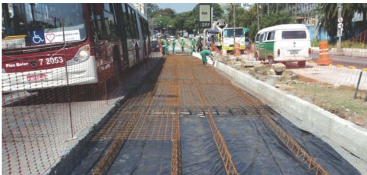
Controle rígido das telas soldadas e das centrais dosadoras garantem qualidade do concreto
